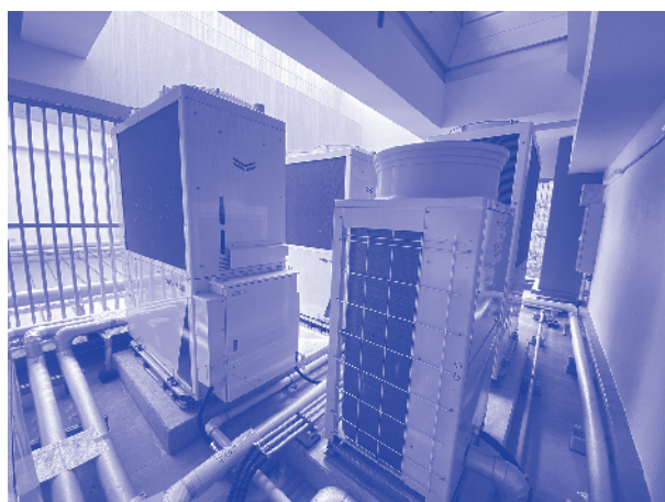
・添田小中学校にある電源自立型GHP（ヤンマー製、20馬力）4台
