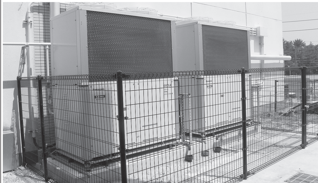
福岡特別支援学校が導入した電源自立型GHP20馬力2台(パナソニック製)
