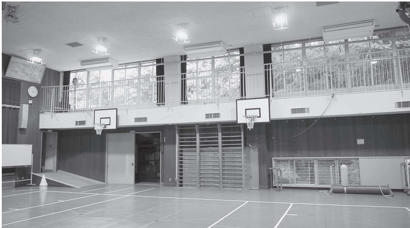
田主丸特別支援学校の校舎2階にある体育室。室内機は3台
