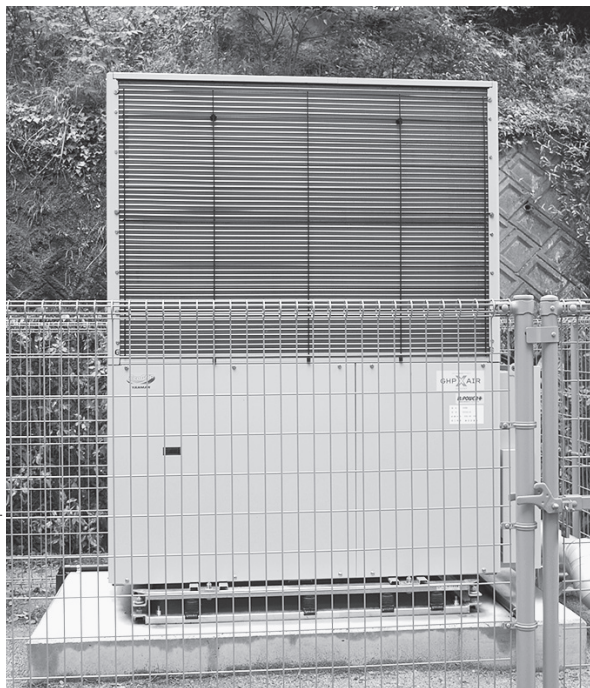
田主丸特支のGHPはヤマエ製の電源自立型20馬力。バルク貯槽の設置スペースを確保できず50kg容器8本で供給する
