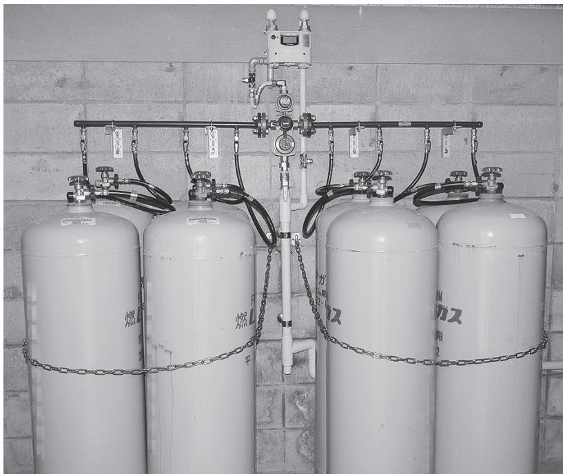
田主丸特支のGHPはヤマエ製の電源自立型20馬力。バルク貯槽の設置スペースを確保できず50kg容器8本で供給する
